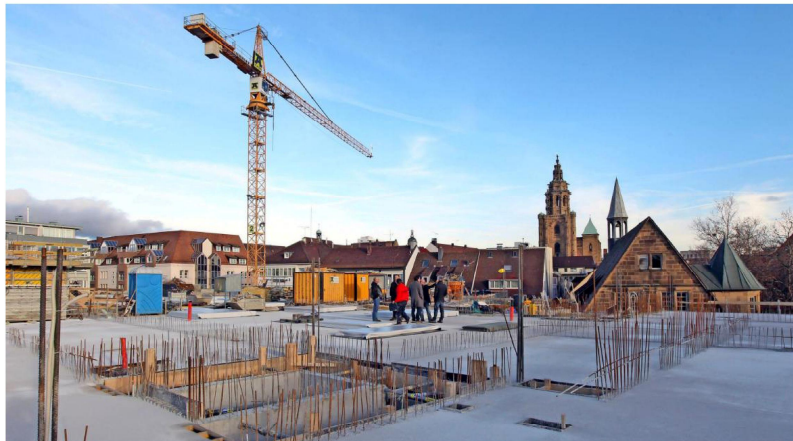
Wohnen mit Aussicht: Auf dieser 60 Zentimeter starken Betonplatte werden in den kommenden Monaten die drei Etagen mit mehr als 50 Wohnungen errichtet.
