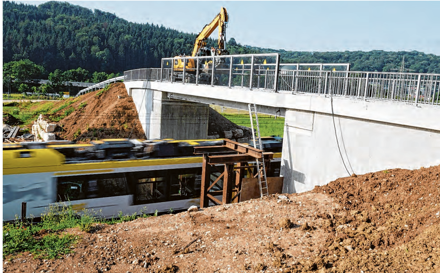
Die Bauarbeiten an der Brücke über den Gleisen beim Birkhof sind fast fertig. Jetzt stehen noch Arbeiten an der Böschung an. Foto: hof
