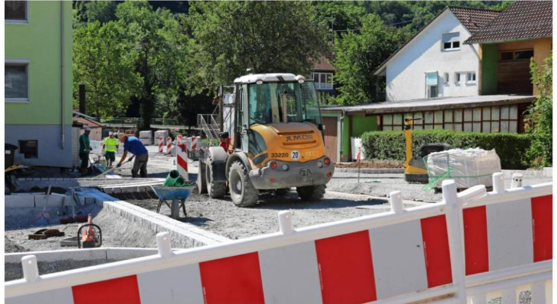
Auf 4800 Quadratmetern wird die Ernsbacher Ortsmitte völlig umgekrempelt: Bis zum Jahresende entsteht der neue Marktplatz zwischen Pachthofscheuer, Kocher und der alten Fabrik. Die Straße wird ebenfalls neu gepflastert.
