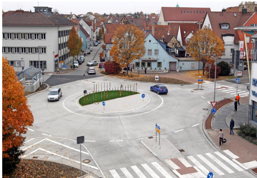
30 Meter Durchmesser, Fahrbahnbreite neun Meter: Zwei der drei Kreisverkehre – hier die Anlage bei der Volksbank, sind schon seit einigen Wochen in Betrieb.
