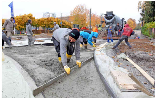
Das geht nur, wenn es nicht regnet: In der vergangenen Woche wurde der Kreisverkehr beim Bürgerzentrum betoniert. Die Verkehrs freigabe ist für die zweite Dezemberwoche geplant. Fotos: Andreas Veigel
