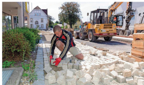
Letzte Arbeiten: Auf den Gehwegen in der Theodor-Heuss-Straße werden in diesen Tagen noch Pflastersteine verlegt.
