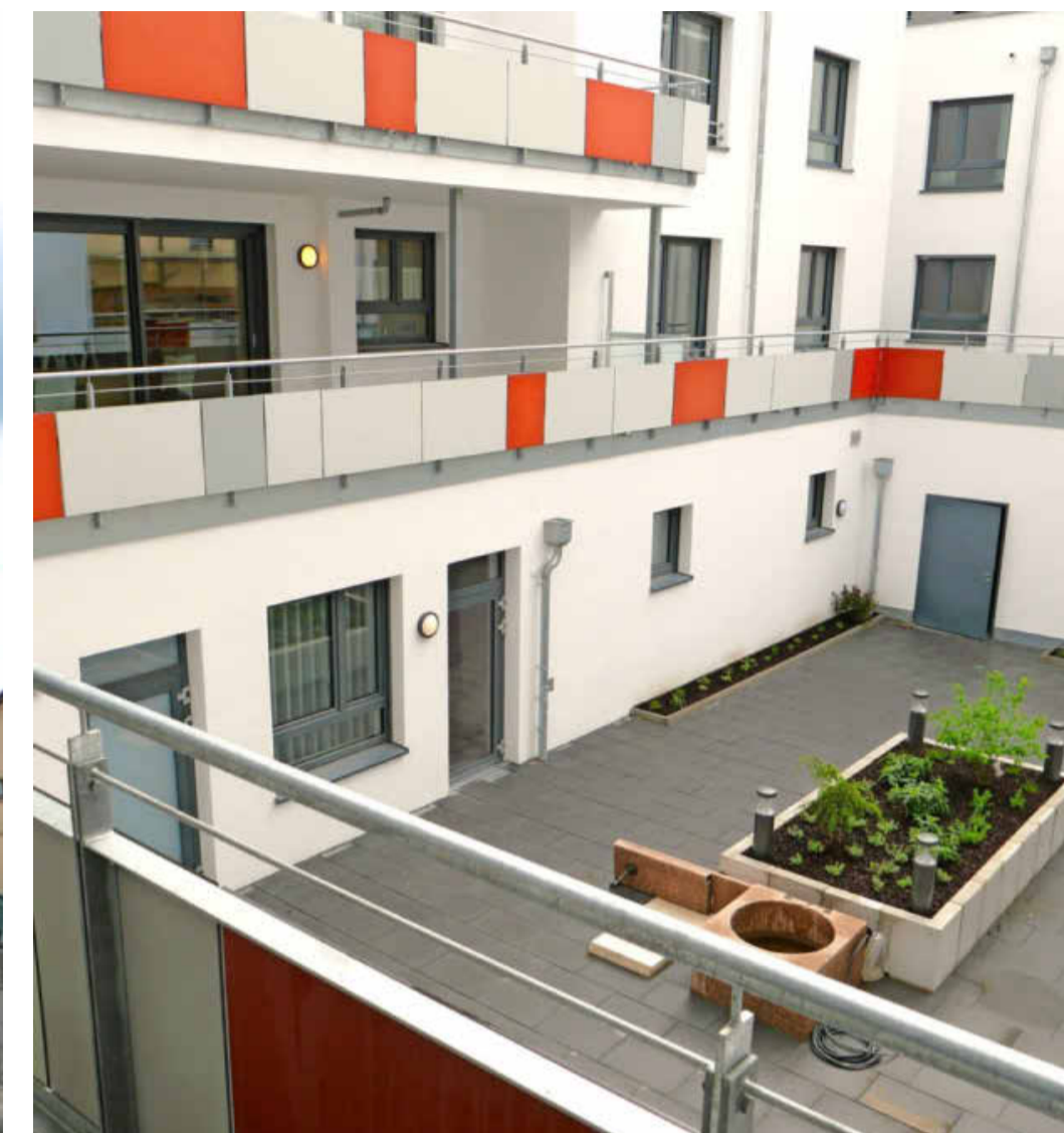
Blick in den Innenhof des Gebäudekomplexes: Er bietet Raum für Erholung und ist zugleich Treffpunkt sowie eine Möglichkeit, um gemeinsame Aktionen und Veranstaltungen durchzuführen.
