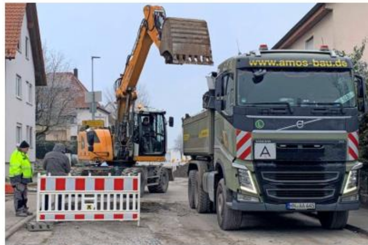
In einem Teil der Ellhofener Straße in Lehrensteinsfeld haben seit Oktober Baumaschinen das Sagen. Im Frühjahr soll alles fertig sein.
